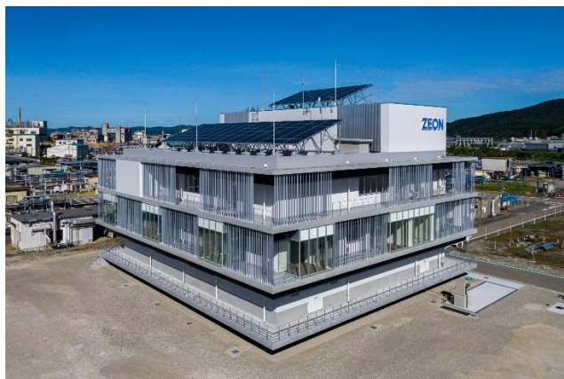
竣工した統合生産センター(IPC)
