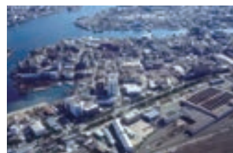
川崎工場・総合開発センター
