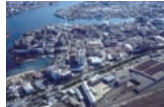
川崎工場・総合開発センター
