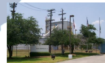
Zeon Chemicals テキサス工場
