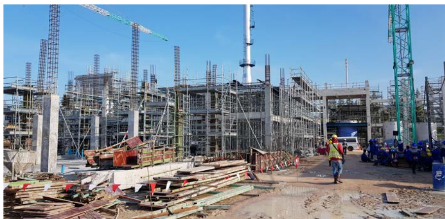
タイ・アクリルゴム工場建設現場
