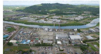
高岡工場全景
