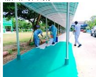
近隣学校の塗装作業奉仕
