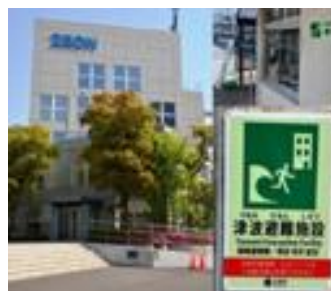
津波避難施設(8号館)
