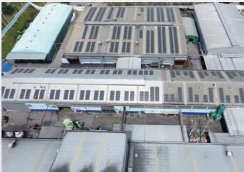
Zeon Advanced Polymix Co., Ltd.では、工場の屋根で太陽光発電を行っています。
