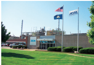
Zeon Chemicals L.P. ケンタッキー工場 [事業内容] 合成ゴムの製造販売
