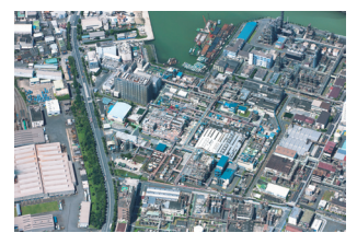
川崎工場・総合開発センター
