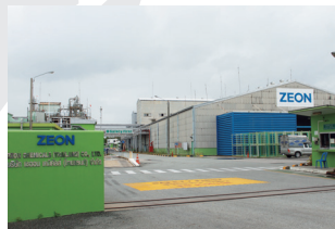
Zeon Chemicals (Thailand) Co., Ltd. [事業内容] 石油樹脂の製造販売
