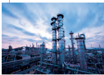
GPB: ゼオン・プロセス・オブ・ブタジエン。C4留分から高純度のブタジエンを抽出する、ゼオンの独自技術
