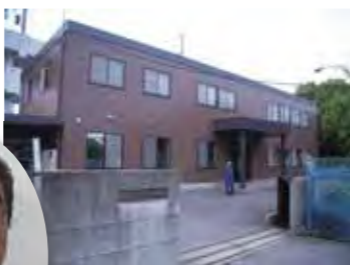
改装された本社事務所
