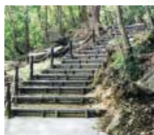
リサイクルプラ製木による階段とチェーン柵
