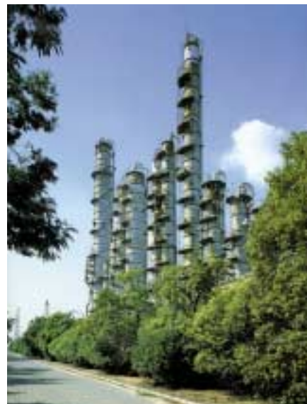
GPIプラント
