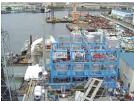
建設中の焼却炉
