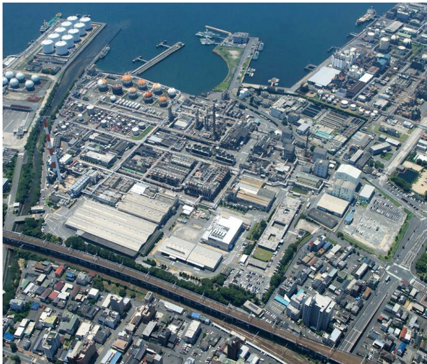
瀬戸内海に面した徳山工場の全景
