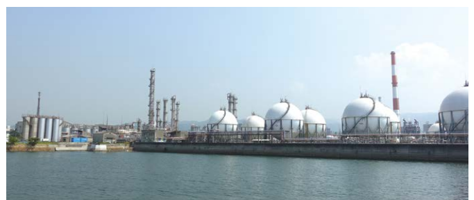
原料を調達・調整する球形タンク群 1千m 3 ×1基、2千m 3 ×3基、3千m 3 ×3基
