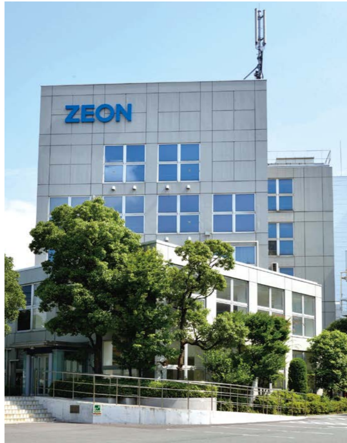
総合開発センター8号館
