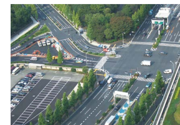
C5石油樹脂が使われるトラフィックペイント
