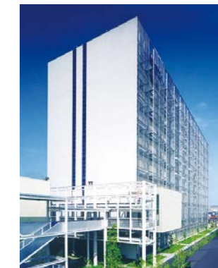
総合開発センター10号館
