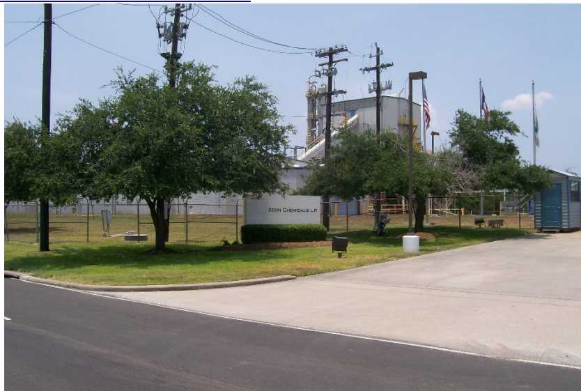
Zeon Chemicals テキサス工場
