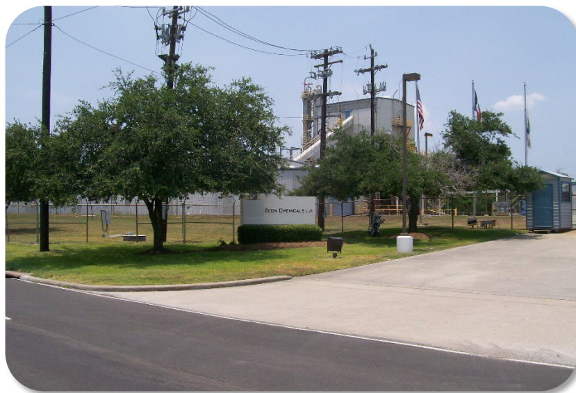
Zeon Chemicals テキサス工場
