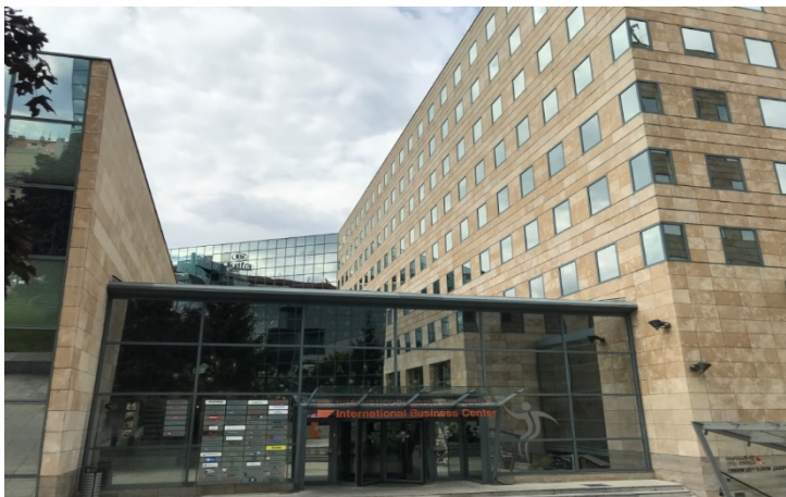
オフィスが入居するビル
