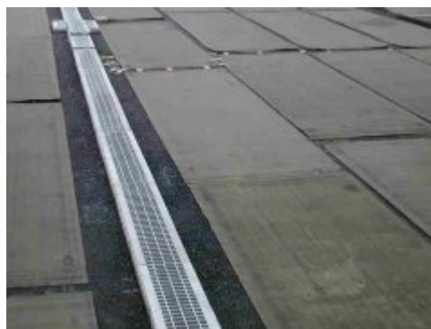
「スノーMZシステム」施工例
