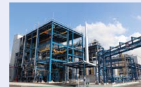
COPのリサイクルプラント 2024年に竣工
