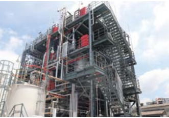
エタノールからの高効率ブタジエン合成ベンチ設備（徳山工場）
