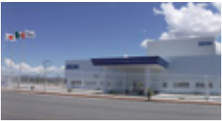
9 Zeon Kasei México S.A. de C.V.
