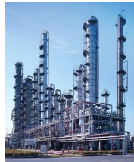
水島工場GPIプラント
