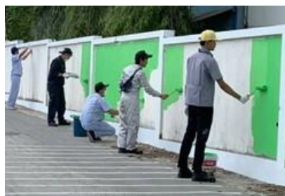
近隣学校の塗装作業奉仕
