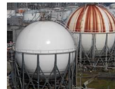
プラント塗替え塗装例(手前/日本ゼオン徳山工場)
