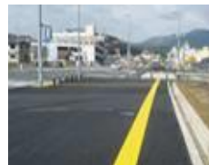
視覚障害者用誘導標示材施工例
