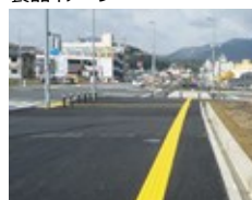
視覚障害者用誘導標示材 施工例
