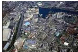
川崎工場全景
