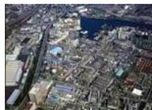
川崎工場全景
