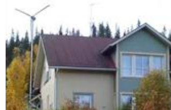
RIMTEC 製樹脂が使用された風力発電設備
