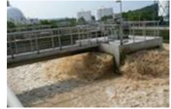
廃水処理施設
