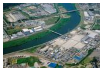
高岡工場全景
