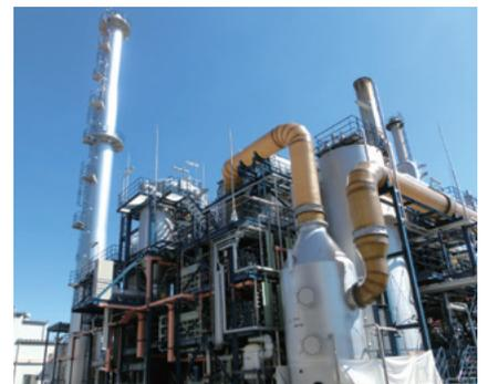
水島工場では、2015年度にボイラー更新にあわせて蓄熱燃焼設備を設置し、熱効率をアップしました。
