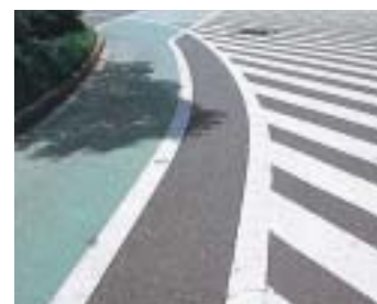
C5石油樹脂が使われるトラフィックペイント
