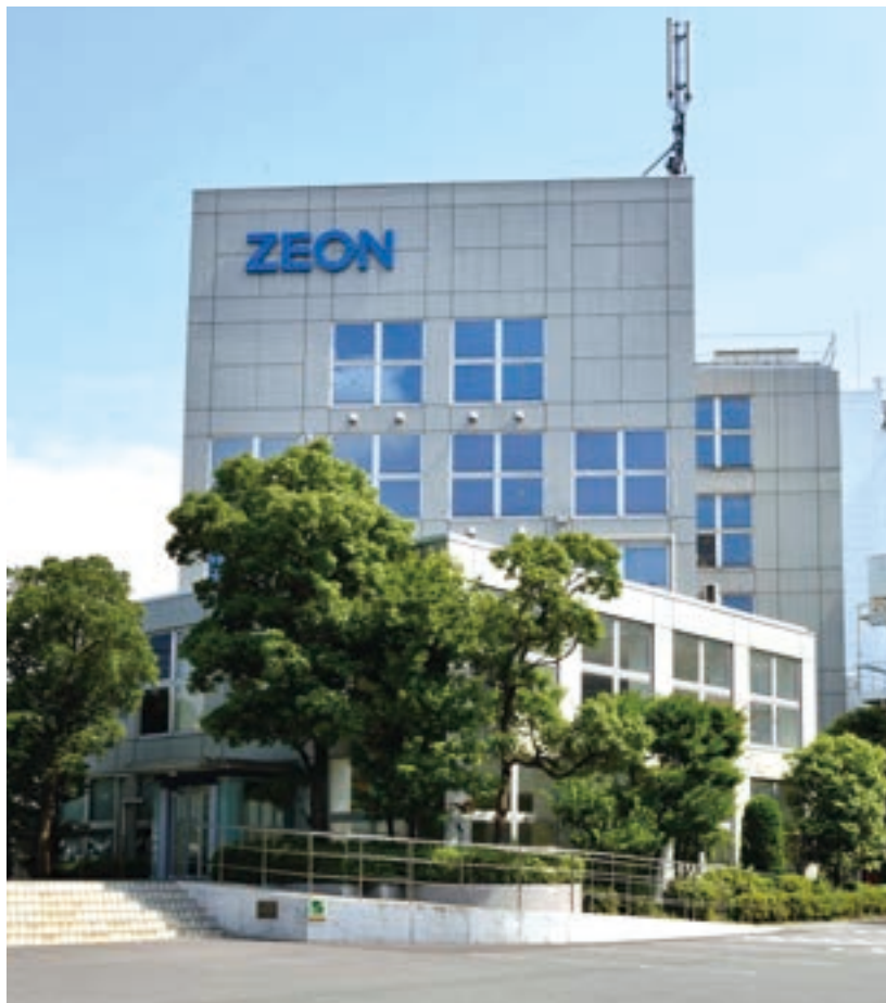
総合開発センター8号館
