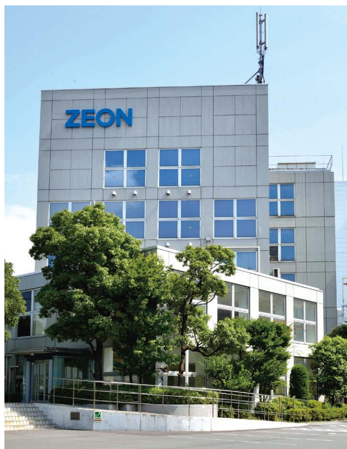
総合開発センター8号館
