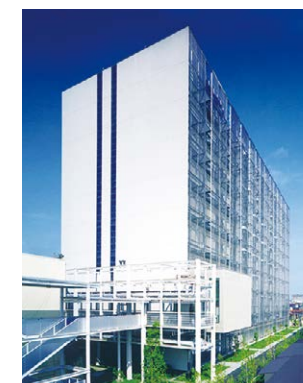
総合開発センター 10号館
