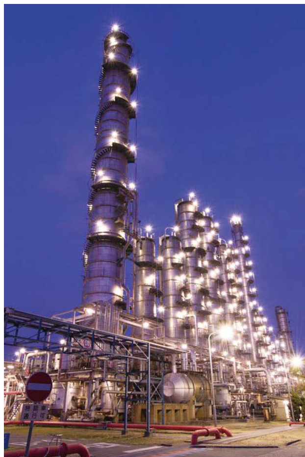
GPIプラント
