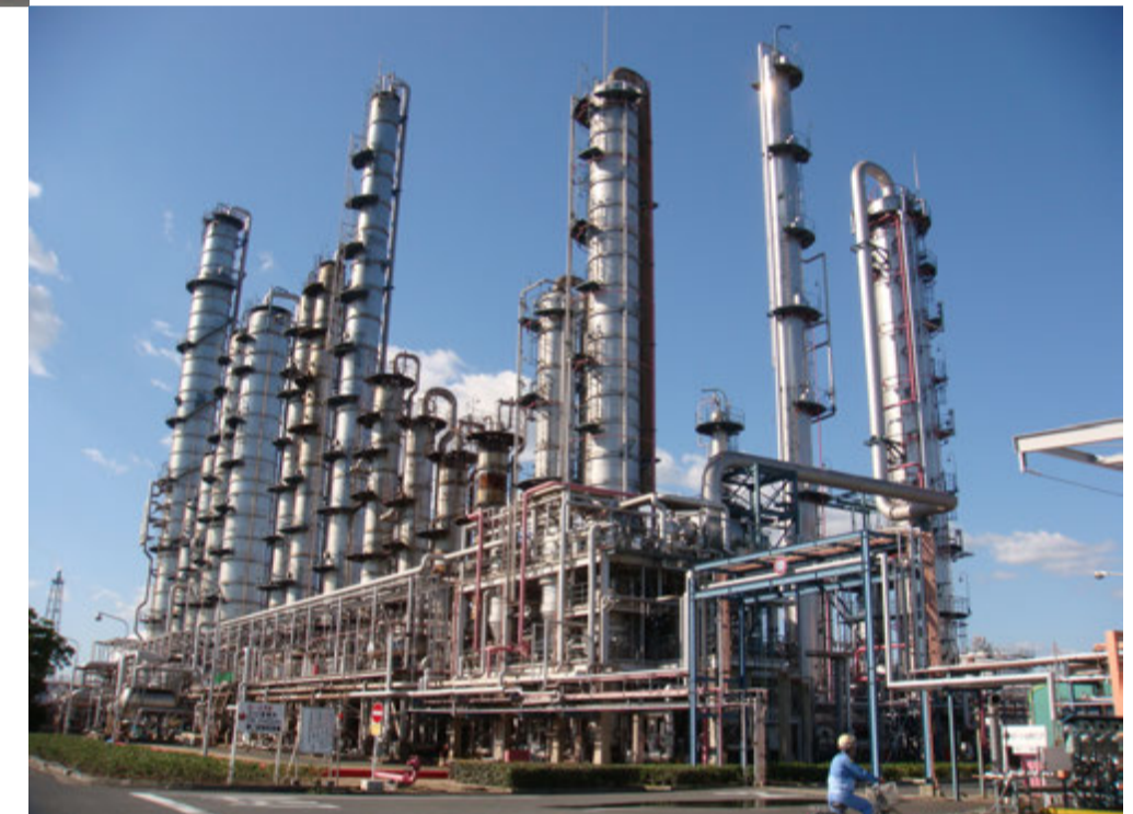
水島工場 GPI プラント
