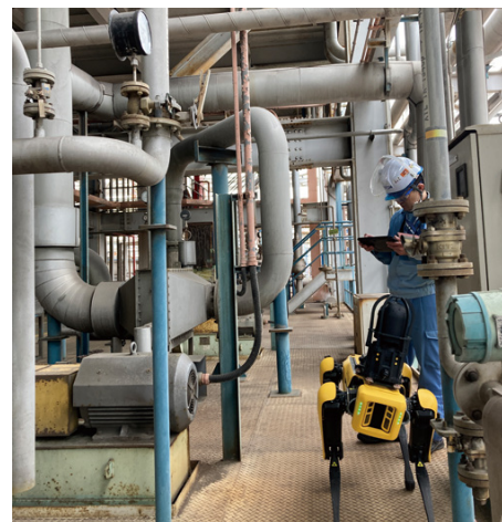
Actual plant inspection tour
