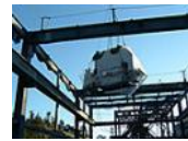
機器据付工事
