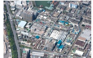
川崎工場全景
