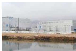
オプテス北陸工場（高岡製造所）
