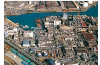
川崎工場全景
