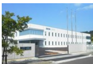
オプテス北陸工場（敦賀製造所）
