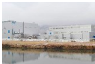
オプテス北陸工場（高岡製造所）
