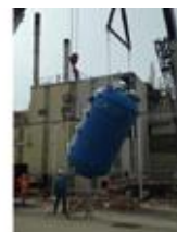
アクリルゴム生産能力増強工事
