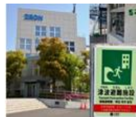
津波避難施設(8号館)
