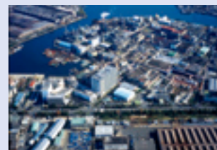
川崎工場・総合開発センター
