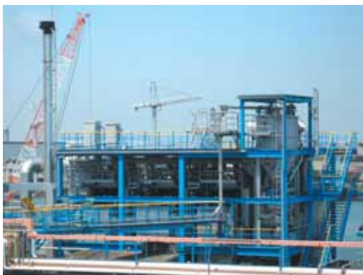
完成した新焼却炉
