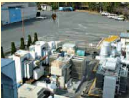
新タービンの取付工事
