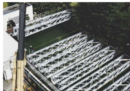
アルミニウム合金製覆蓋設置工事
